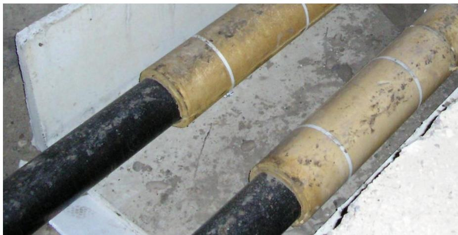
Рисунок 32 – Трубопроводы отопления с изоляцией, канальная прокладка.
